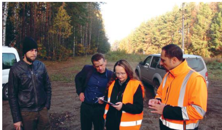
Przekazanie placu budowy - drogi powiatowe
