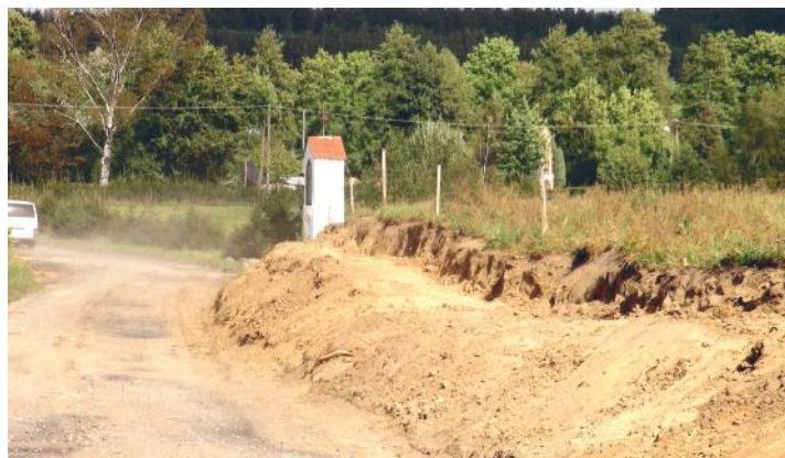
Modernizacja drogi Godki - Porbady
